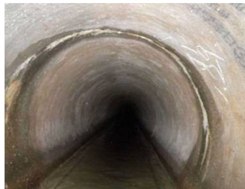
写真5 腐食のない管渠
