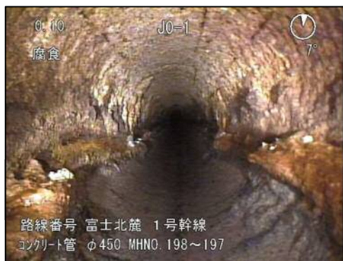
写真4 調査箇所下流管渠
