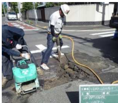
pic1 舗装切断・撤去
