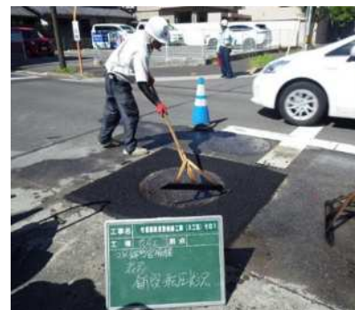
pic3 蓋・受枠交換 復旧
