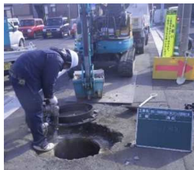
pic2 蓋・受枠撤去
