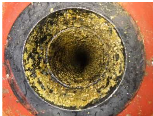
図2 清掃後（汚泥棟連絡管廊）
