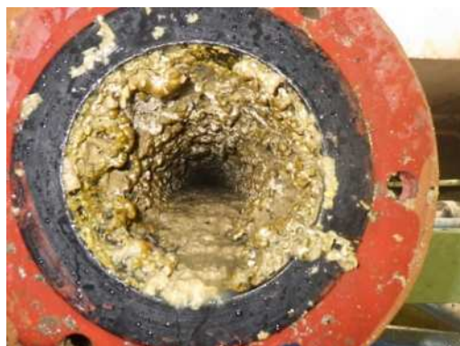
図1 清掃前（汚泥棟連絡管廊）
