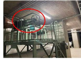
写真6 初沈流出流量計バルブ
