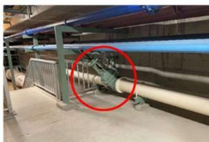
写真3 曝気沈砂池棟元バルブ（初沈管廊）
