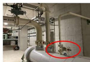
写真4 初沈流出水路曝気バルブ（反応タンク管廊）
