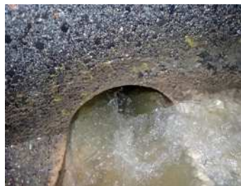
図2 坂井4号マンホールポンプ吐出先マンホール
